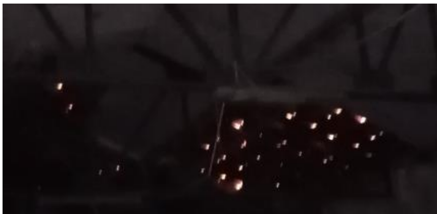
Luz entrando por orificios en la cubierta
